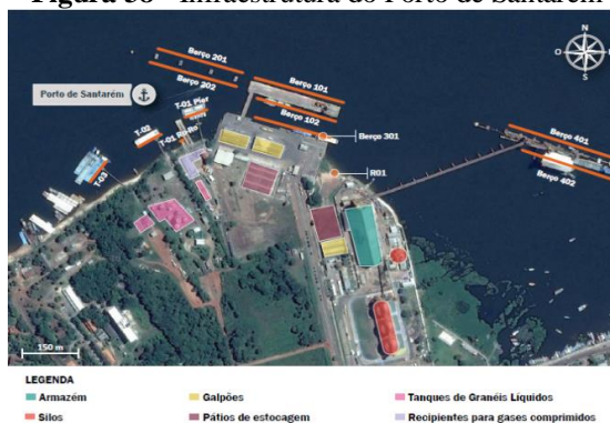
Figura 38 - Infraestrutura do Porto de Santarém
