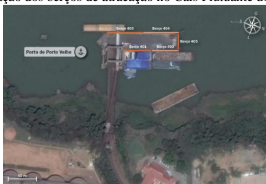
Figura 43 – Localização dos berços de atracação no Cais Flutuante do Porto de Porto Velho
