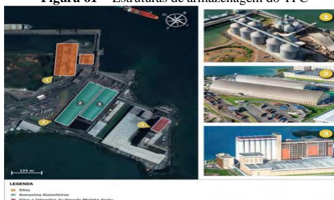
Figura 61 - Estruturas de armazenagem do TPC
