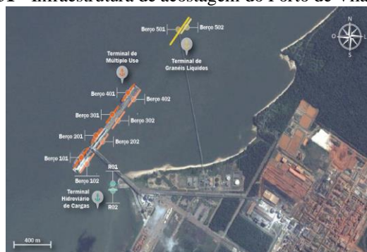
Figura 31 - Infraestrutura de acostagem do Porto de Vila de Conde
