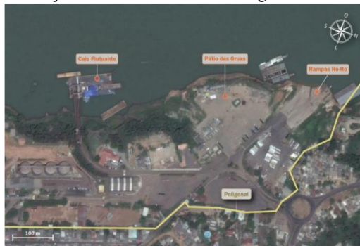
Figura 41 - Localização das estruturas de acostagem do Porto de Porto Velho
