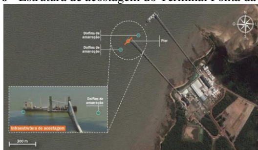
Figura 36 - Estrutura de acostagem do Terminal Ponta da Montanha
