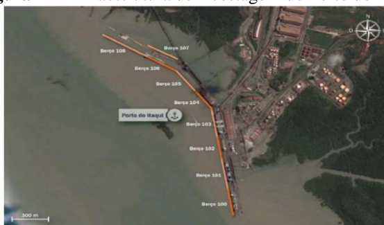
Figura 47 - Infraestrutura de Acostagem do Porto do Itaqui
